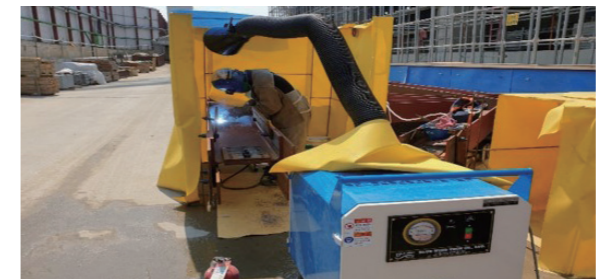
간이 칸막이 및 이동식 집진 시설 설치 현장
